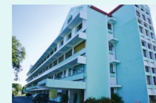
エンジニアリングビル(工学部)
